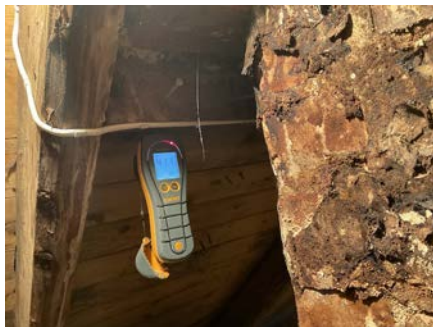
Fuktmåling rundt pipe.
