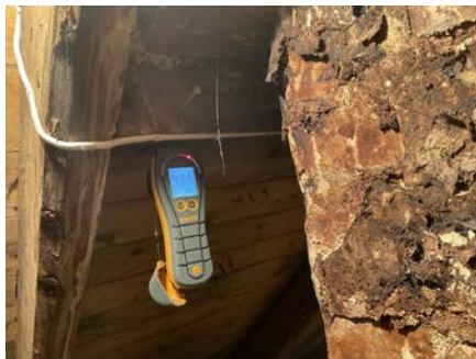
Fuktmåling rundt pipe.
