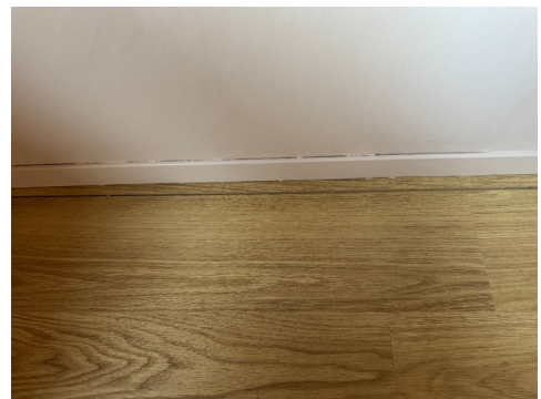
Glip i laminatgulv inntil vegg på soverom 2.
