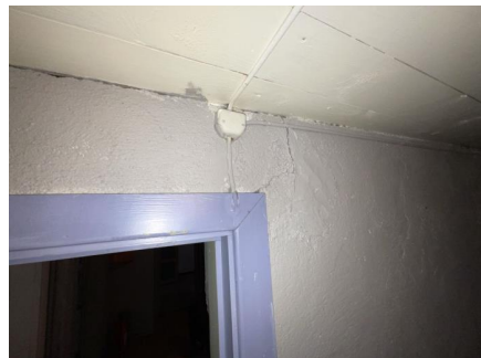
Riss/mindre sprekker er synlig i kjeller
