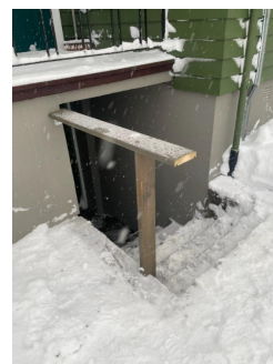
Rekkverk er montert etter befaringen.
