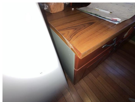
Skade på kantlist benkeplate
