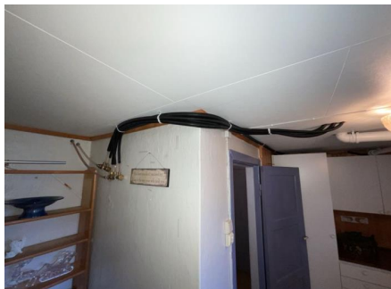
Åpne rør og fordelerkolber montert på vegg
