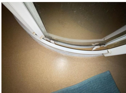
Ett hjul på dusjdør er skadet/borte
