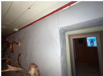
Riss/mindre sprekker er synlig i kjeller
