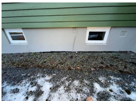
Riss/mindre sprekker er synlig i kjeller
