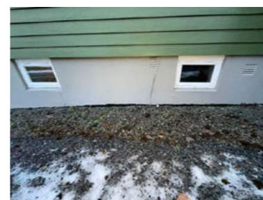
Riss/mindre sprekker er synlig i kjeller
