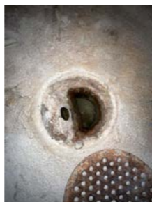
Soilsluk uten membran/tettesjikt på gulv
