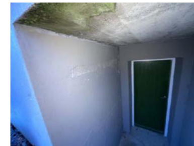
Saltutslag er synlig under repo på trapp som følge av manglende membran/teking under terrassebord
