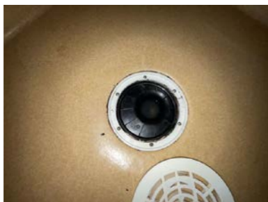
Vinylbelegg er ført ned under skrudd klemring i sluk.
