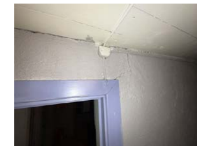
Riss/mindre sprekker er synlig i kjeller
