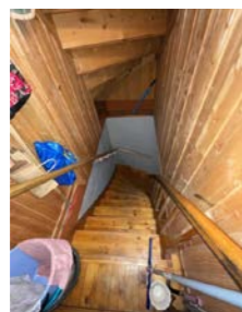
Trapp sett fra 1. etasje ned mot kjeller
