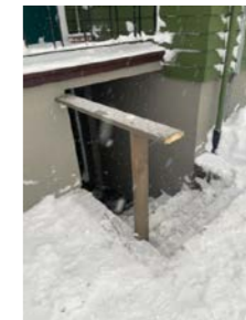
Saltutslag er synlig under repo på trapp som følge av manglende membran/teking under terrassebord
