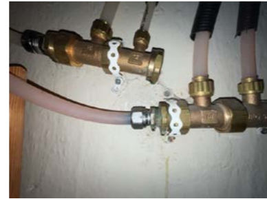
Drypplekkasje fra fordelerkolbe er utbedret etter befaringen av Bakken VVS
