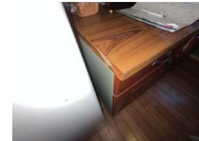
Skade på kantlist benkeplate
