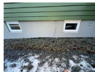
Riss/mindre sprekker er synlig i kjeller
