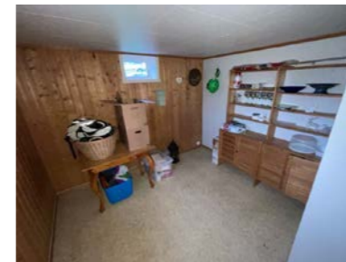
Oversikt lagerrom hvor det ble foretatt hulltaking i innforet yttervegg
