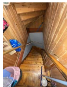
Trapp sett fra 1. etasje ned mot kjeller
