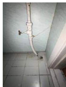
Plastrør frem til hovedstoppekrane
