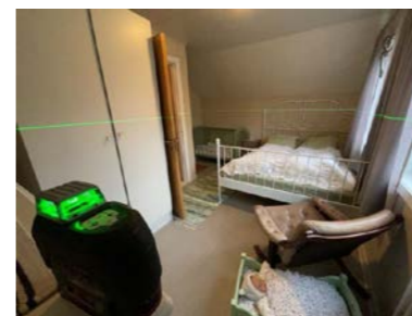
Loft. Plassering av laser ved kontroll av soverom 1. Det er målt 10 mm høydeforskjell gjennom rommet. TG 1
