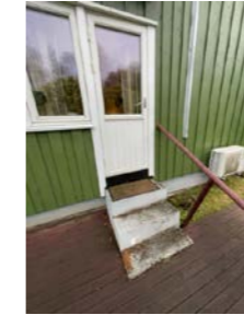
Trapp fra terrasse til stue i betong med håndløper på en side.
