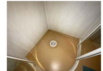
I bunn av plater i dusj er det fuget
