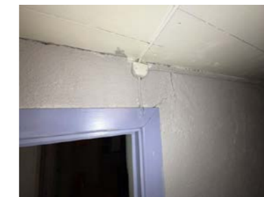
Riss/mindre sprekker er synlig i kjeller
