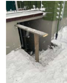
Saltutslag er synlig under repo på trapp som følge av manglende membran/teking under terrassebord
