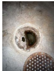
Soilsluk uten membran/tettesjikt på gulv
