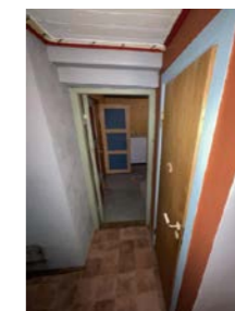
Dører i kjeller til toalettrom og boder
