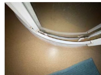
Ett hjul på dusjdør er skadet/borte
