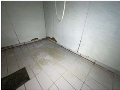
Synlige skader på våtromsplater
