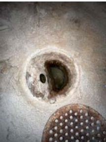
Soilsluk uten membran/tettesjikt på gulv
