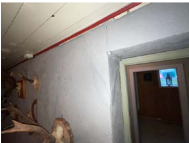
Riss/mindre sprekker er synlig i kjeller
