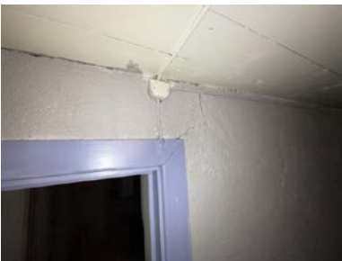
Riss/mindre sprekker er synlig i kjeller
