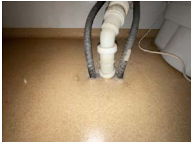
Rørgjennomføringer i gulv bør fuges og sikres på en bedre måte. Ingen synlig skade i området.
