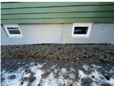
Riss/mindre sprekker er synlig i kjeller
