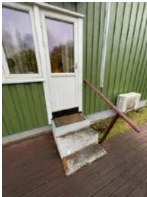
Trapp fra terrasse til stue i betong med håndløper på en side.
