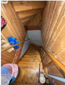
Trapp sett fra 1. etasje ned mot kjeller
