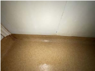
Liten kantskade på laminat ved plateskjøt i dusj.
