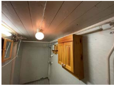
Åpne rør inne på dusjrom
