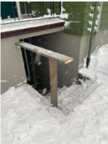
Rekkverk er montert etter befaringen.
