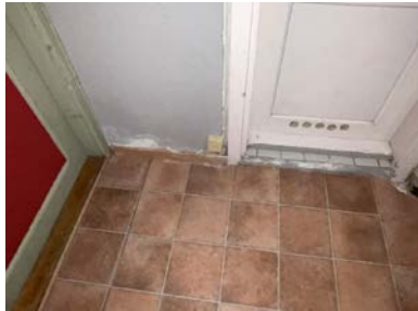
Synlig saltutslag i gang ved dør mot gang og mot dusjrom
