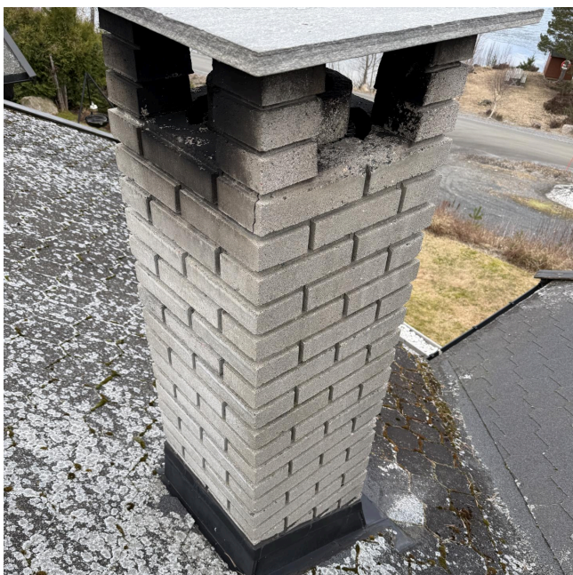
Pipe over tak
