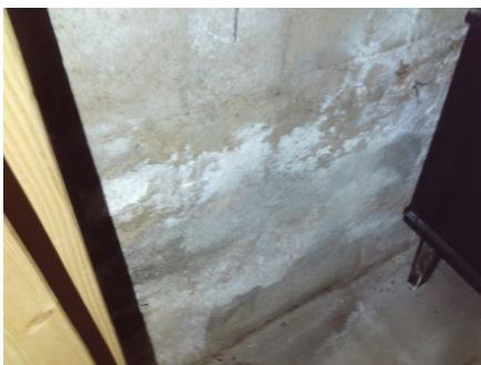
Fuktmerker på grunnmur.
