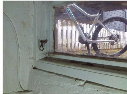
Eldre slitte kjellervinduer.
