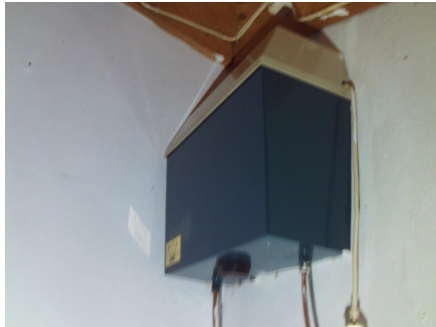
Eldre dagtank med noe røropplegg
