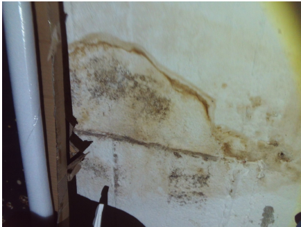
Fuktmerker på grunnmur.
