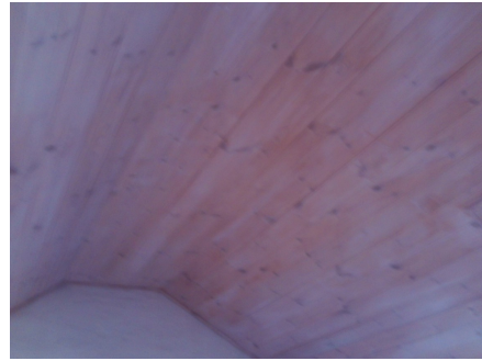
Deler av lukket takkonstruksjon.
