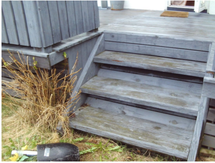
Enkel trapp til terrasse i fra have.
