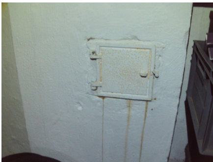
Sotluke i grovkjeller.
