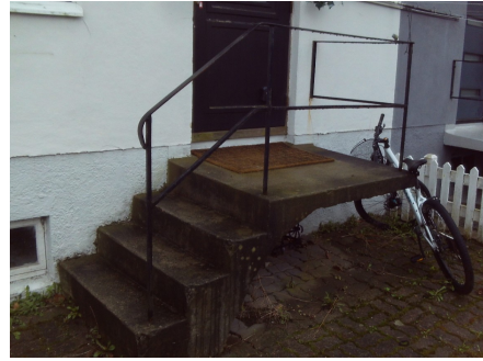
Støpt trapp til inngangsparti
