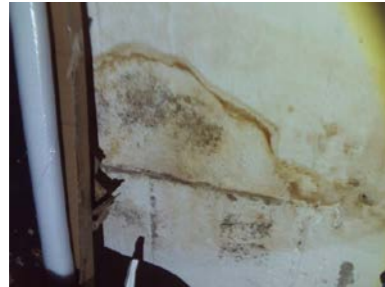
Fuktmerker på grunnmur.
