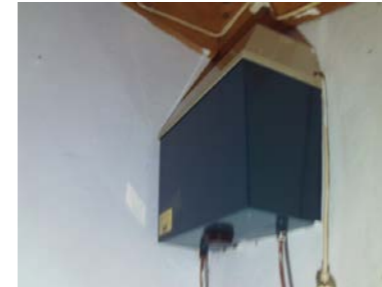
Eldre dagtank med noe røropplegg
