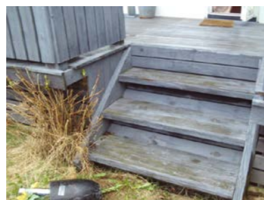
Enkel trapp til terrasse i fra have.
