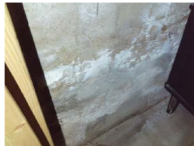
Fuktmerker på grunnmur.
