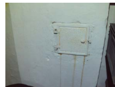
Sotluke i grovkjeller.
