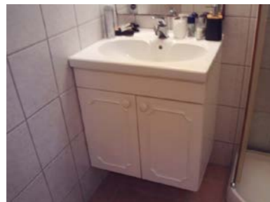
Noe eldre innredning
