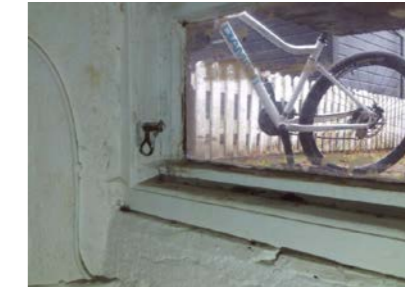
Eldre slitte kjellervinduer.
