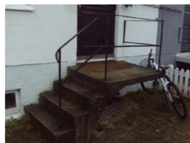
Støpt trapp til inngangsparti
