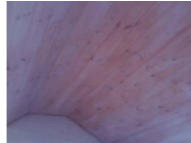
Deler av lukket takkonstruksjon.
