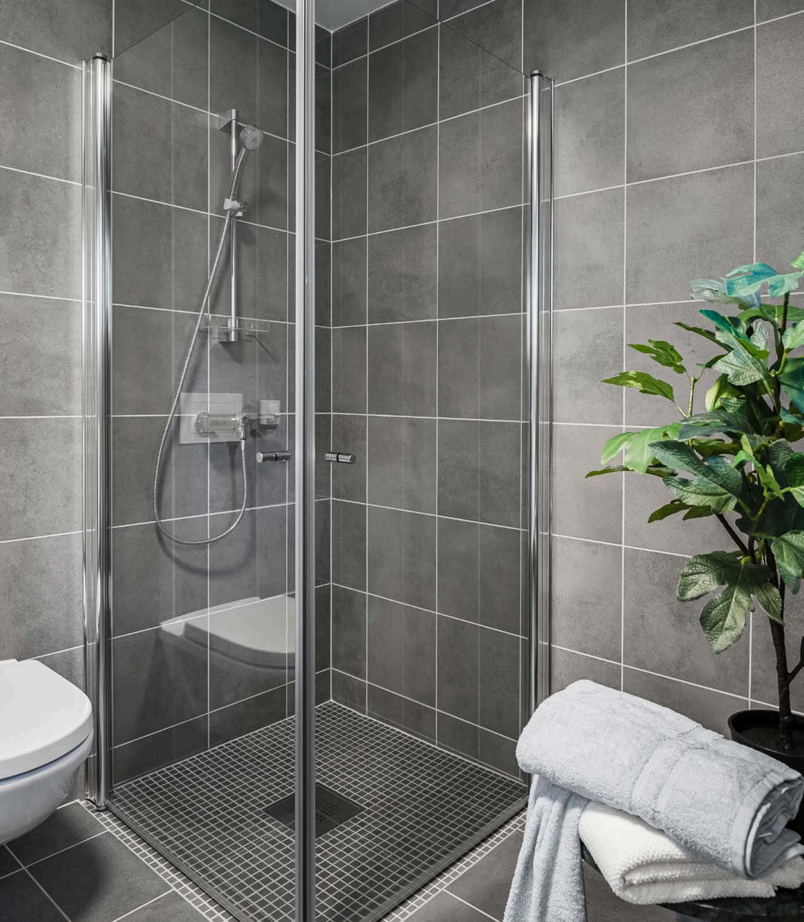
Dusjhjørne med glassdør og mosaikkfliser på gulv. Vegghengt toalett.
