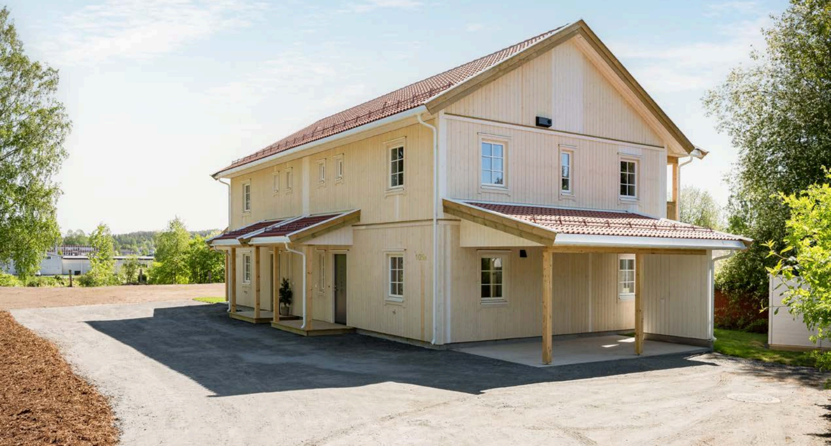
Vertikaldelt tomannsbolig med inntilbygget carport.
