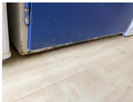
Eksempel på slitasje.
