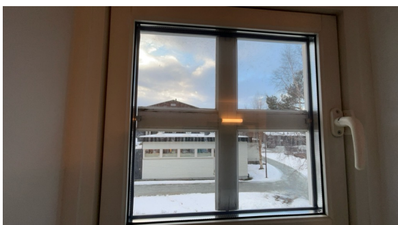
Bilde viser vindu på bad
