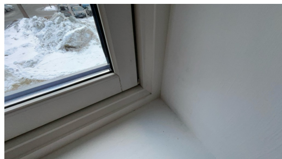
Utett mellom karm og vindu.
