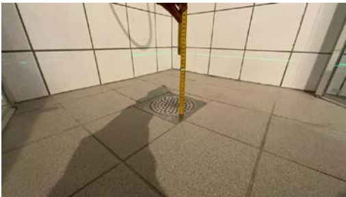
Målt topp slukrist
