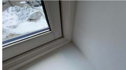
Utett mellom karm og vindu.
