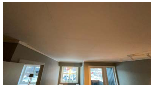
Oversiktsbilde tak på stue
