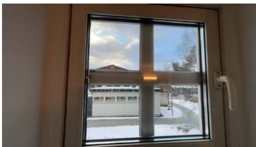
Bilde viser vindu på bad
