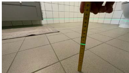
Målt gulvrområde med motfall ved yttervegg siden av dør.
