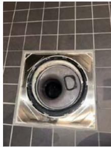
Plastsluk med klemring for membran leilighet
