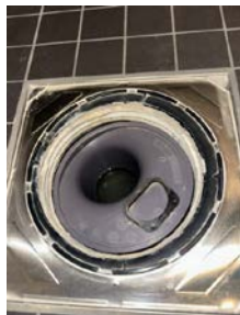
Plastsluk med klemring for membran hybel
