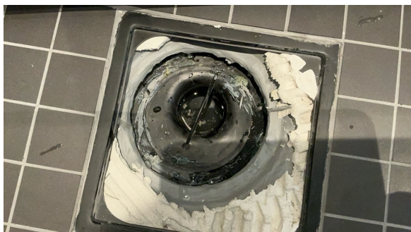
Sluk i dusjsone.
