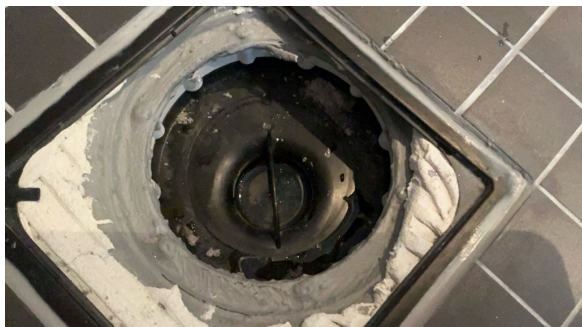
Sluk i dusjsone. Bad 2. Etasje.
