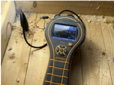
Måling av relativ luftfuktighet i opplettet gulv i kjølerom kjeller.
