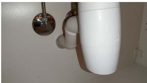
Kontroll av røropplegget.
