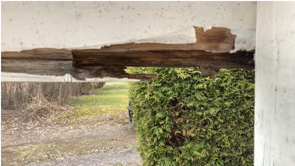
Råteskadet rekkverksbord.
