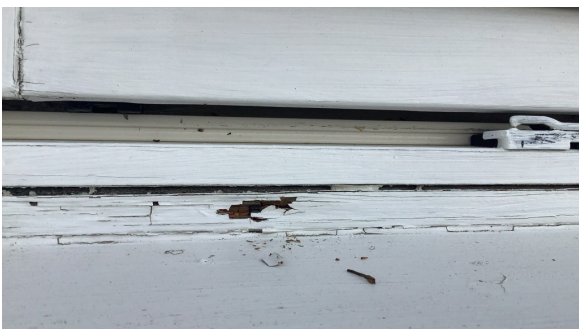
Råteskadet vindu.
