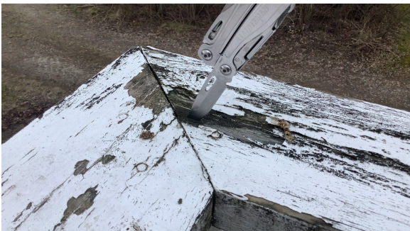
Råteskadet håndløper.
