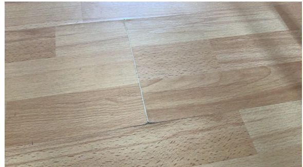
Svellskadet laminatgulv.
