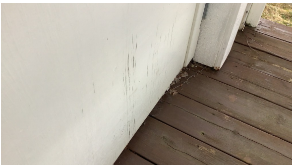
Svelling på dørblad i første etasje.
