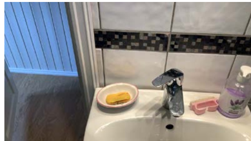
Dør er plassert i den definerte våtsonen ved servant.
