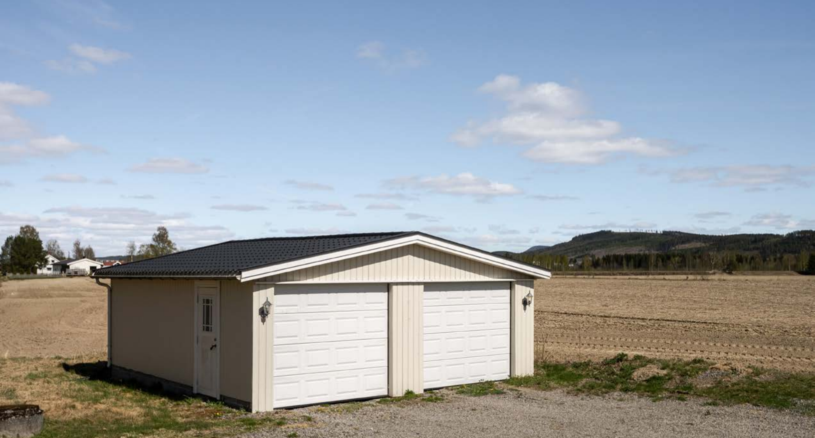
Den doble garasjen ble bygget i 2014. Det er innlagt strøm og to leddporter med elektriske motorer.
