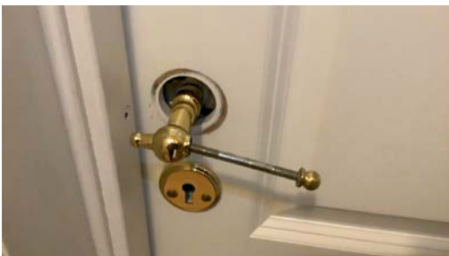
Eksempel på vrider som mangler skilt og trehylse.
