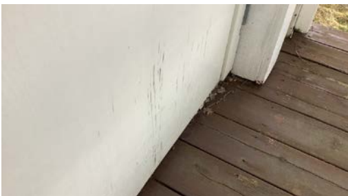
Svelling på dørblad i første etasje.
