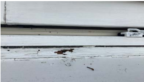
Råteskadet vindu.
