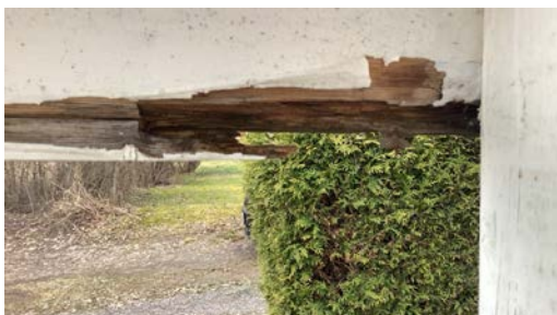
Råteskadet rekkverksbord.
