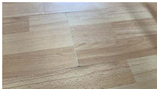
Svellskadet laminatgulv.
