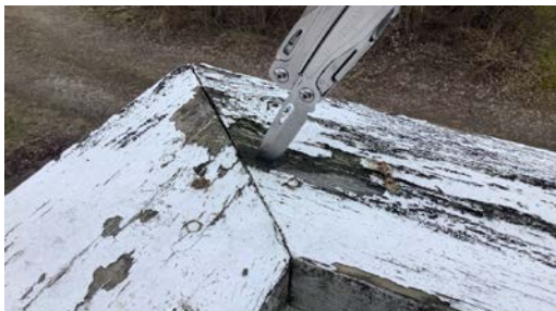
Råteskadet håndløper.
