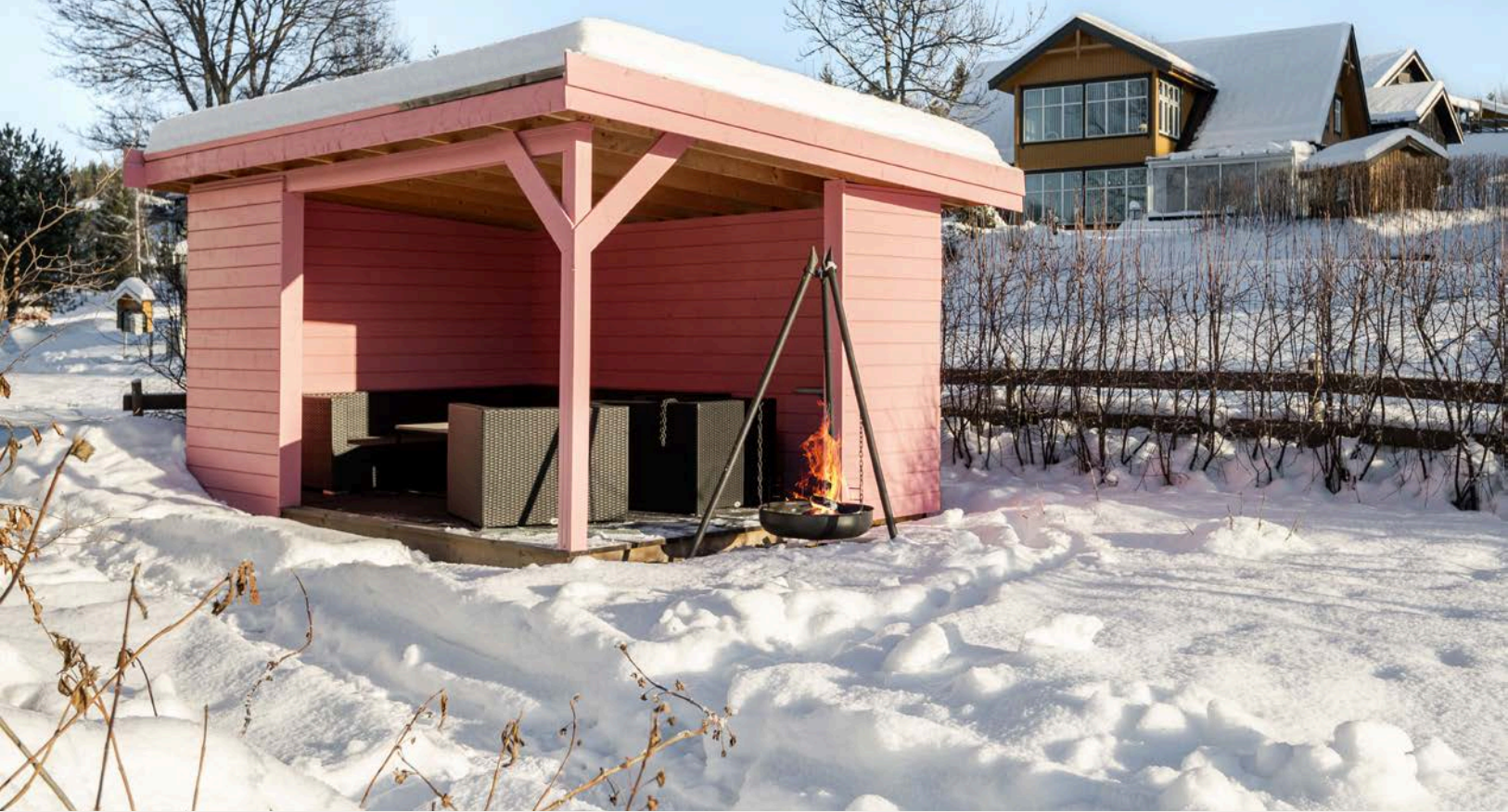
Koselig uteplass med overbygget platting og plass til sittegruppe.
