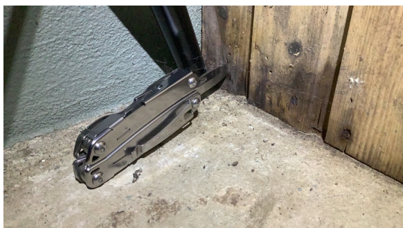
Råteskadet panel på delevegg mellom boder.
