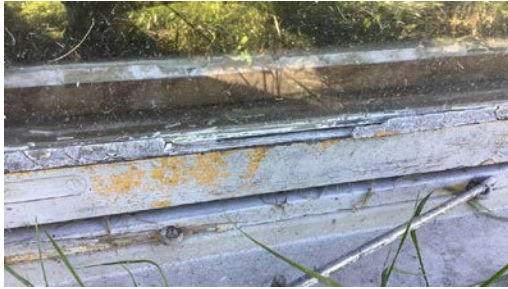
Eksempel på værslitt kjellervindu.
