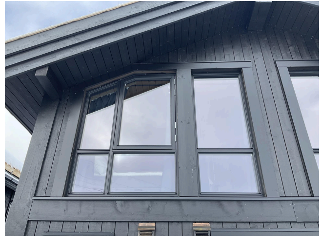
Vinduer er utført med beslag.
