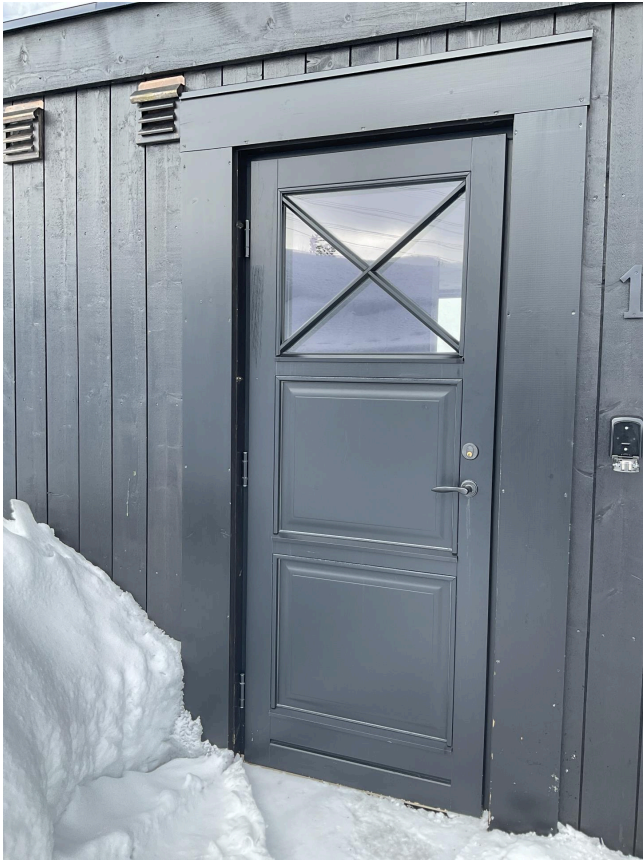
Utførelse av ytterdør
