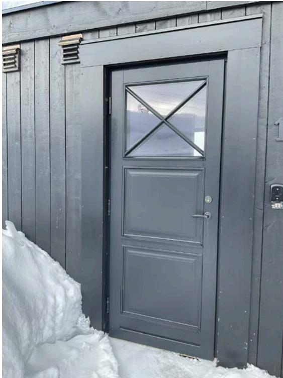
Utførelse av ytterdør
