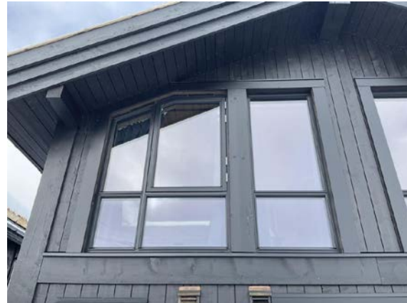
Vinduer er utført med beslag.
