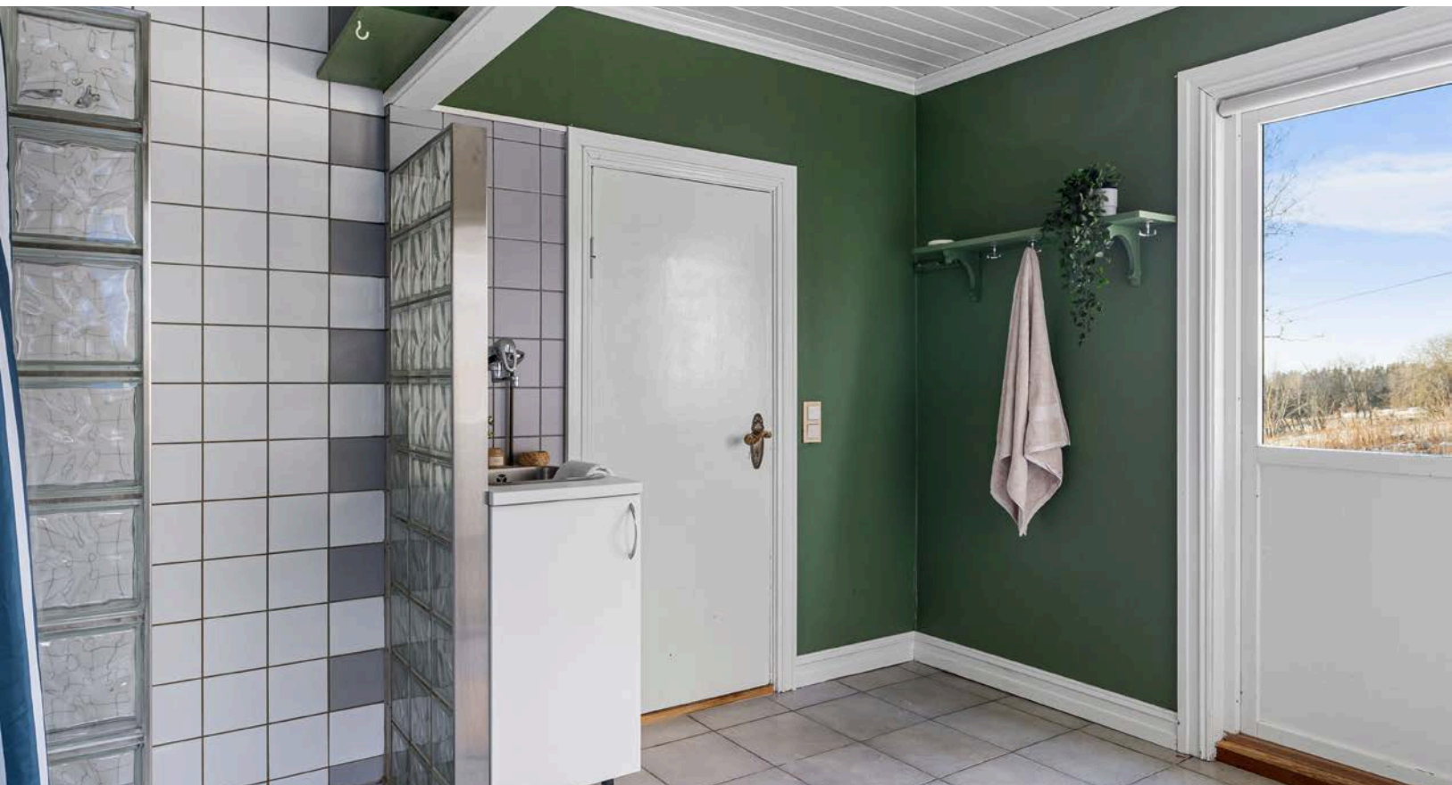
Baderommet har fått TG3 og må oppgraderes for å tåle normal bruk etter dagens krav.
