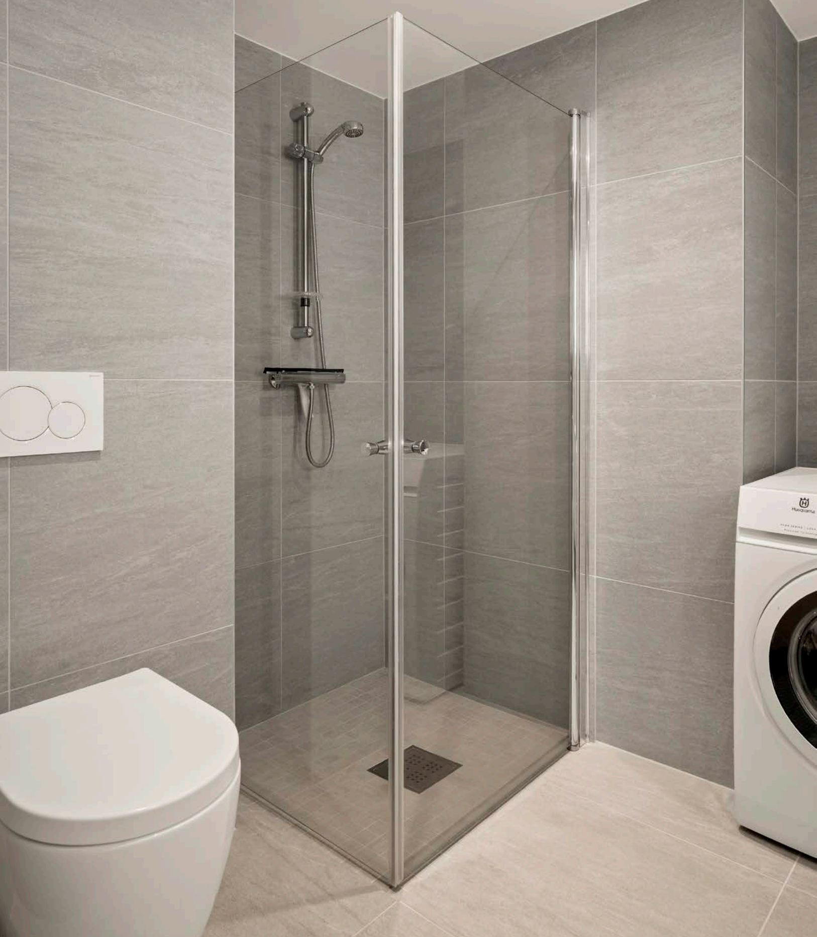
Dusjen er plassert i nedsenket nisje i hjørnet og har dører i glass, dusjarmaturet er håndholdt.
