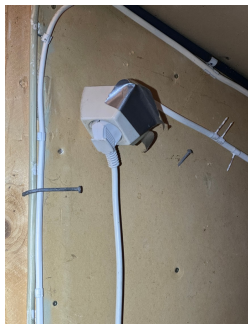
Løs stikkontakt i den utvendige boden.
