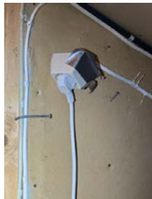
Løs stikkontakt i den utvendige boden.
