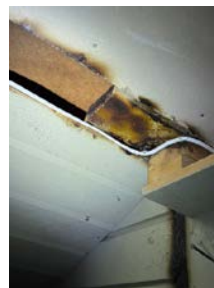
Tidligere brannspill i den utvendige boden
