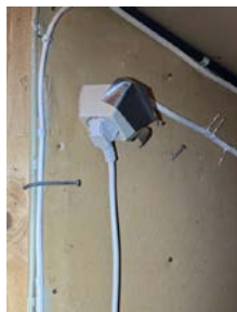
Løs stikkontakt i den utvendige boden.
