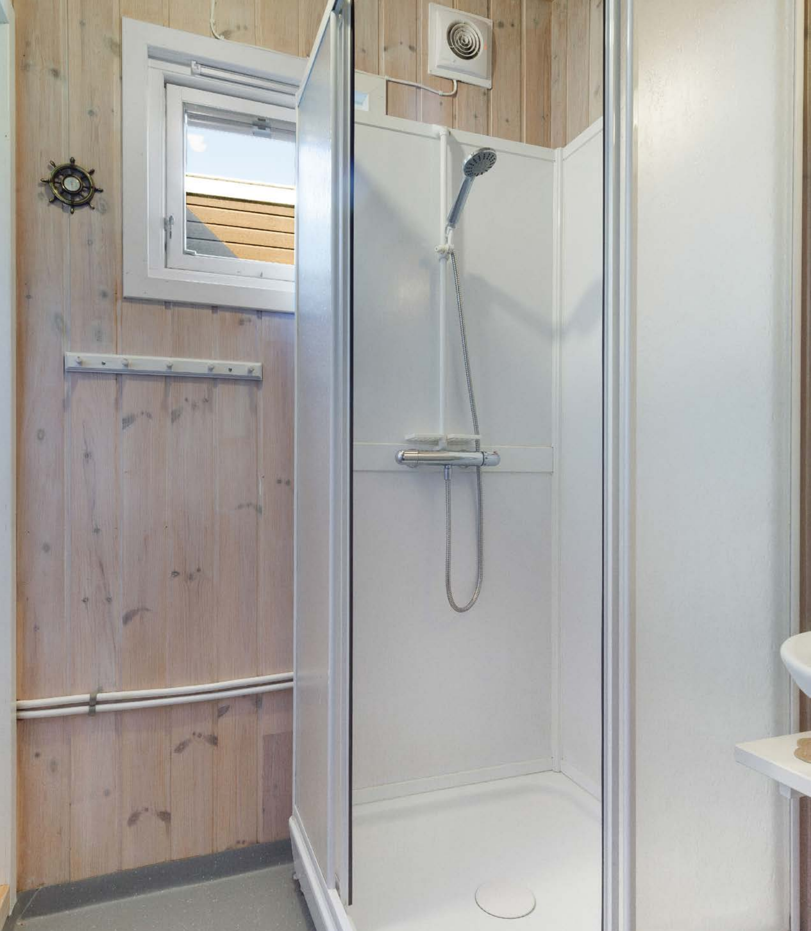
Badet inneholder toalett, sevant og dusj. Belegg på gulvet og panel på veggene gir et robust og funksjonelt våtrom.
