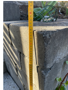
Støttemur over 50 cm fra terreng uten sikring
