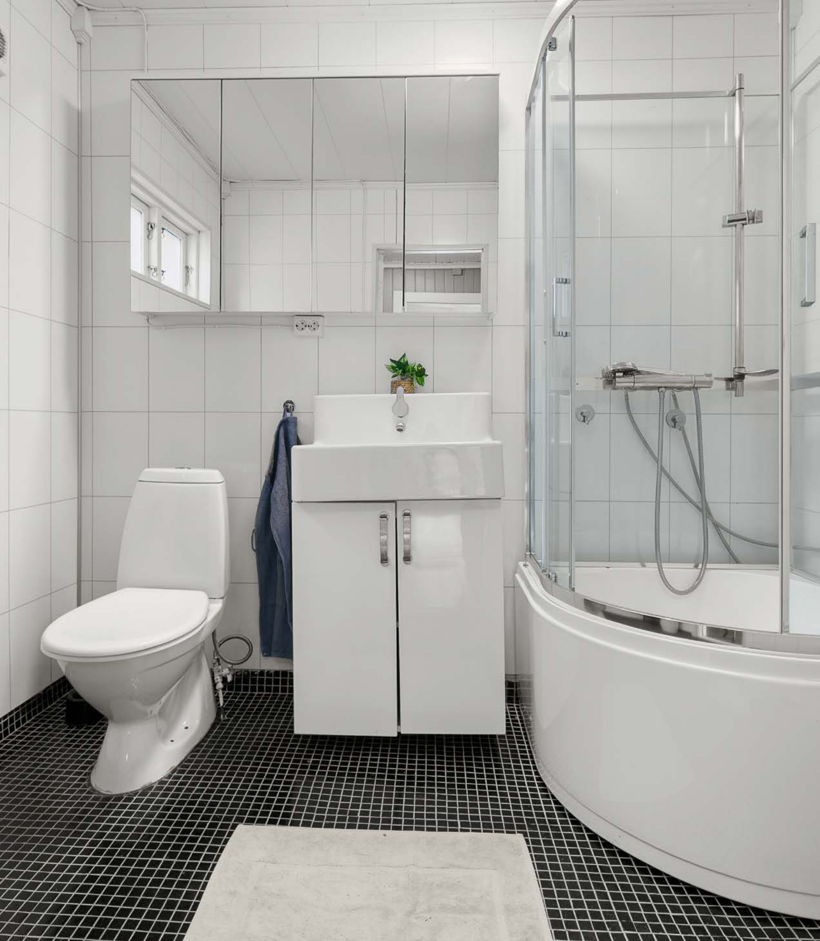
Badet har flis på gulv med varmekabler og våtromsplater på vegg. Lukket kabinett, servant i innredning og wc.
