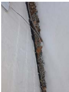
Synlig knotteplast på grunnmur.
