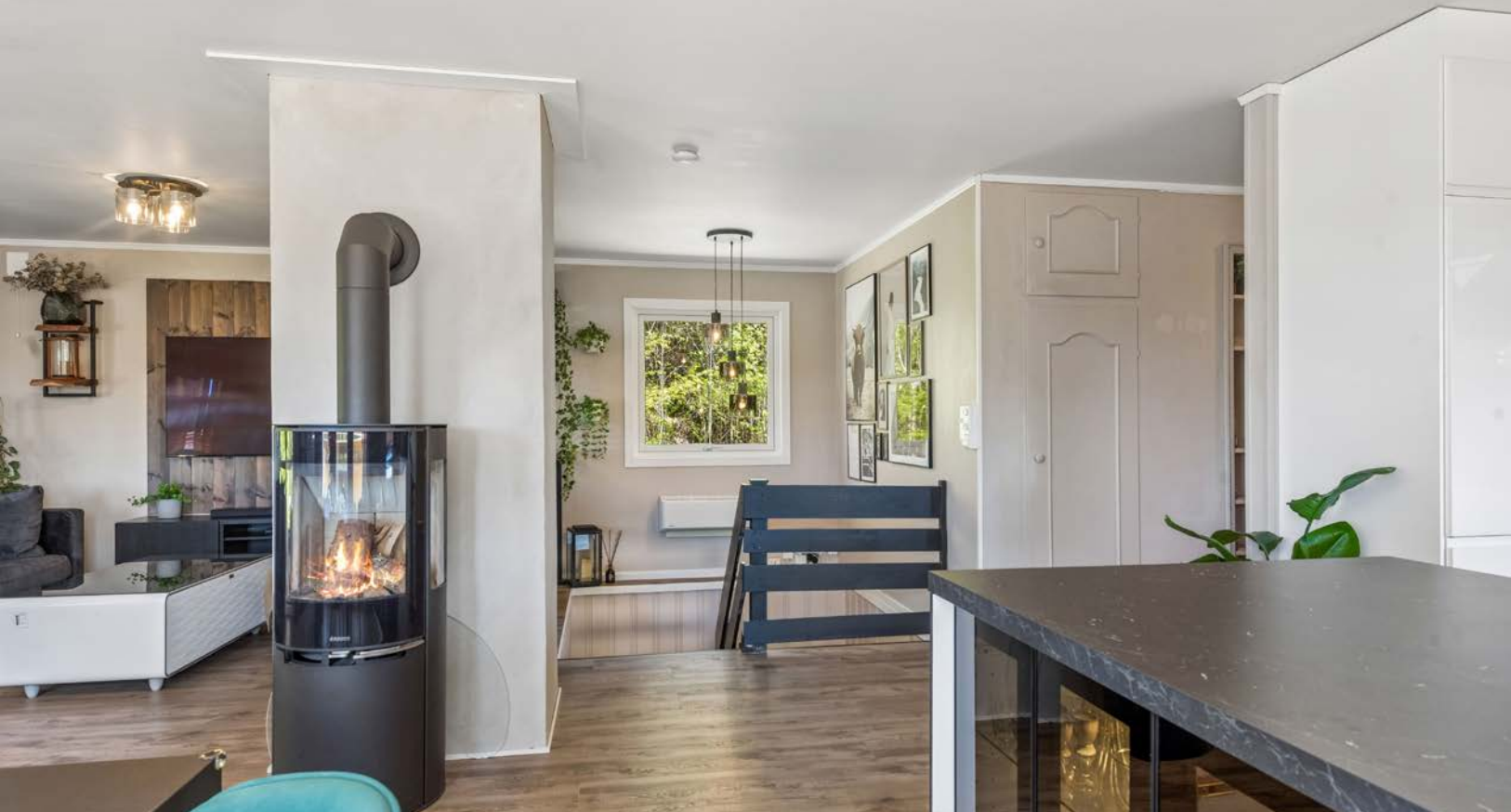
Det er også en varmepumpe i trappløpet.
