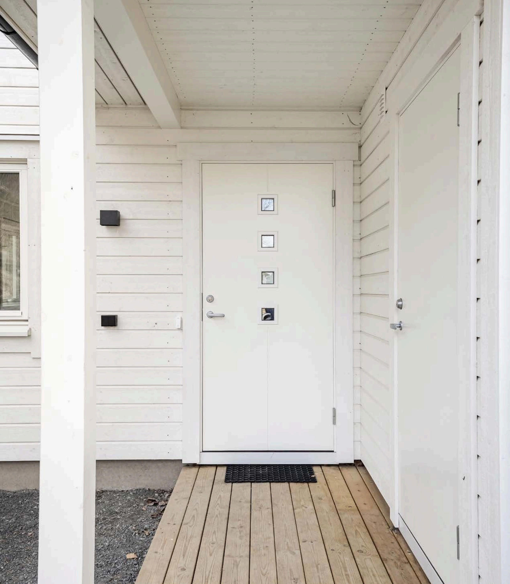
Montert ringeklokke, utebelysning og utvendig stikkontakt på vegg ved inngangsdøren.
