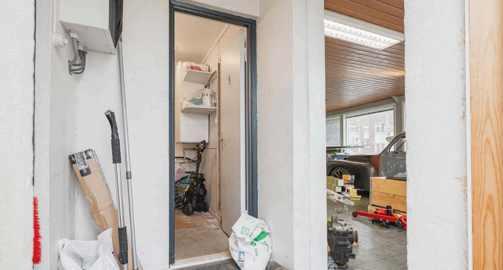
Enkel standard med belegg på gulv og lysmalt puss/betong på veggene.
