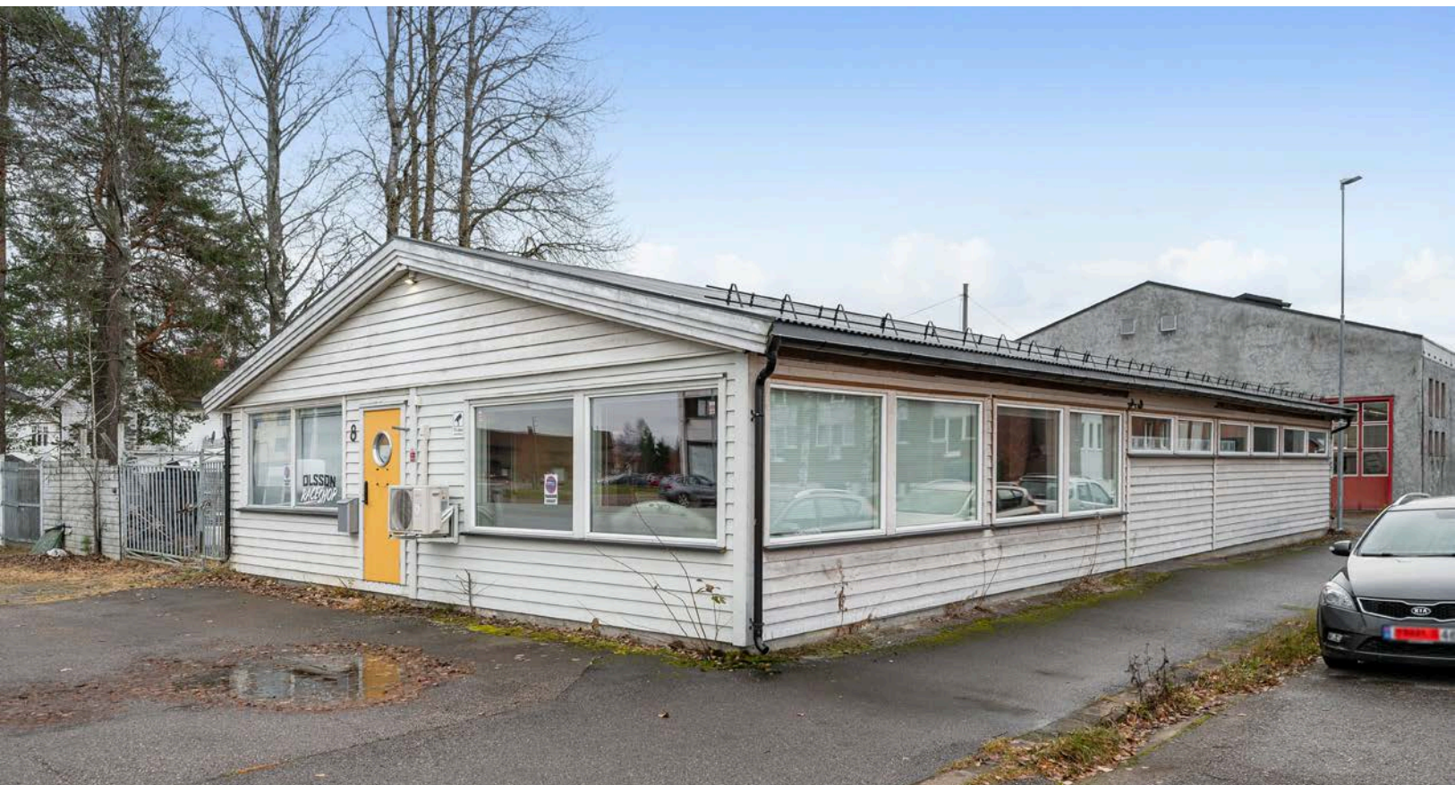
Bygget har et bruksareal på 191m 2 og inneholder vindfang, toalettrom, kontor/lager, lager/verksted og et lite lagerrom.
