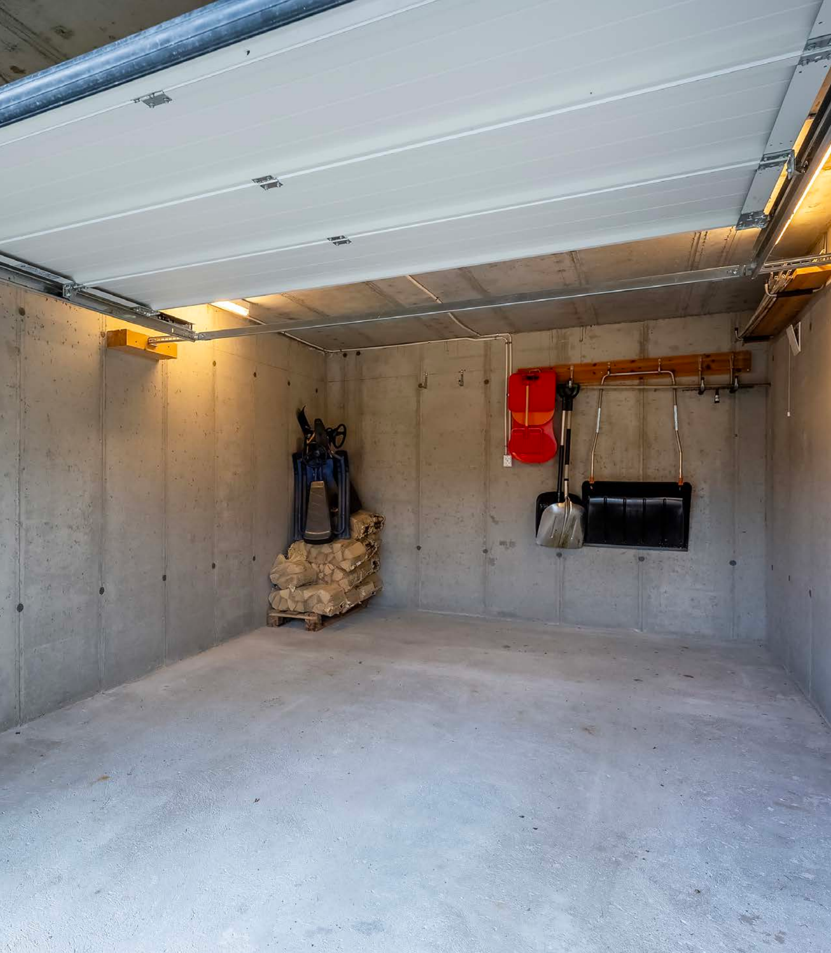
Garasjerom på ca. 20 m 2 i sokkeletasjen
