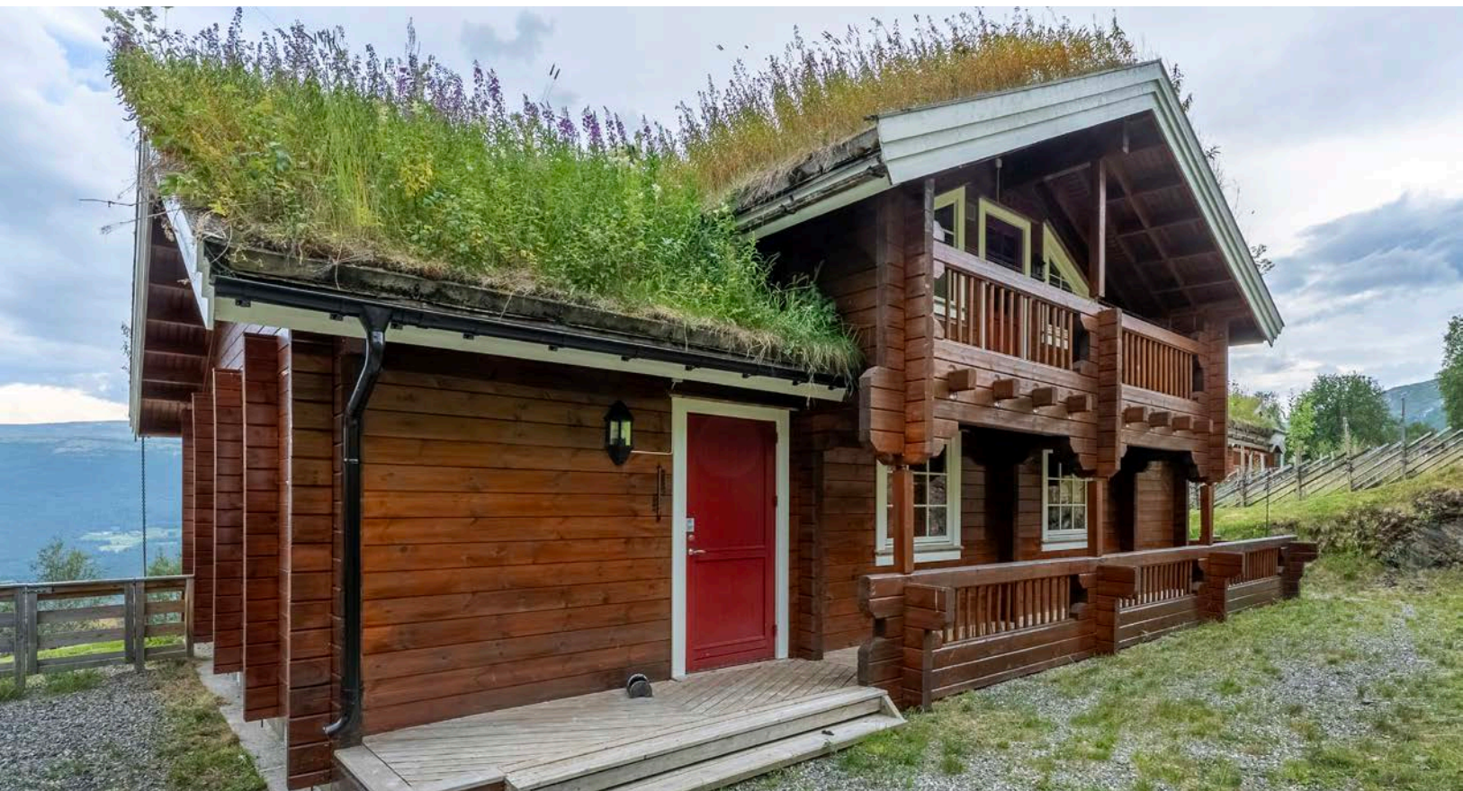
Hytta ble oppført i 2008 - Inngangsparti med terrasse som strekker seg rundt tre sider av bygget
