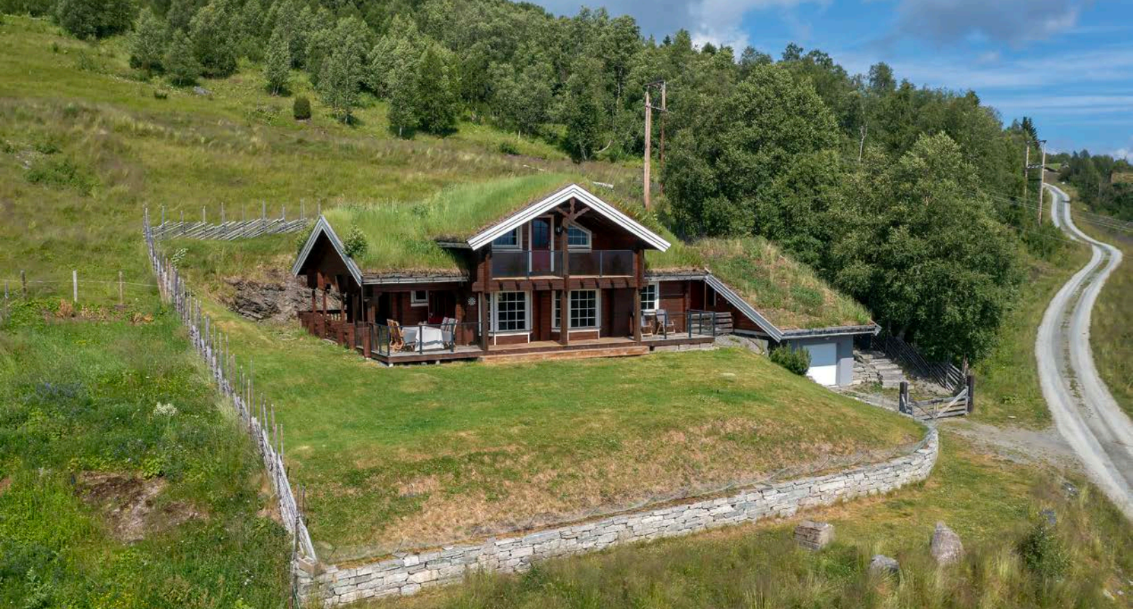
Tomten er pent opparbeidet og innrammet av skigard med adkomst via grind samt støttemur i naturstein
