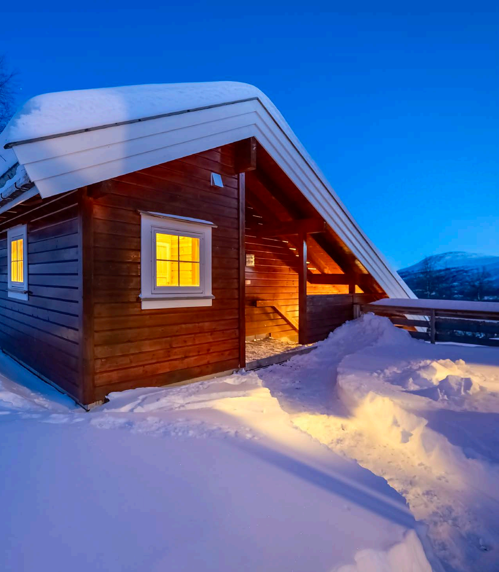
Anneks med garasje ble oppført i 2014 Takoverbygd trapp fra gårds plass til inngangsnivå er svært praktisk vinters tid
