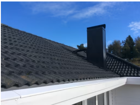
Yttertak. Inntekket pipe.
