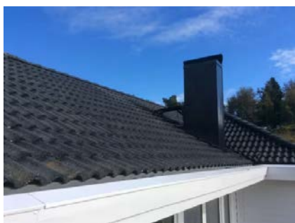
Yttertak. Inntekket pipe.
