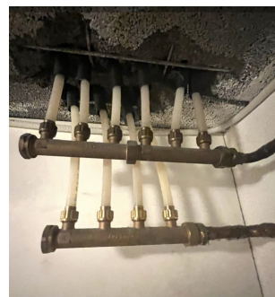
Fordelerstokker rør i rør i himling - Teknisk rom.
