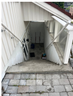
Hybel B - Vestside: Utvendig kjellertrapp.
