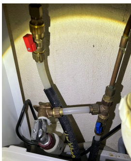
Kjøkkenbenk Hybel B: Løst feste. Ikke tettemuffer, Noe irring på kobber.
