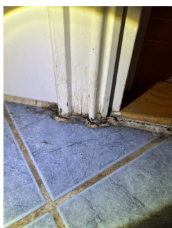
Svelling i nedkant skap og skade på dør.
