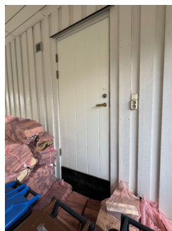
Ytterdør: Kontor- overbygd uteareal.
