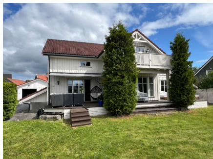
Terrasse mot hagen.
