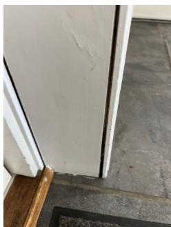
Ytterdør: Innvendig dørutforing og dørlist.
