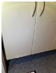
Svelling i nedkant skap og skade på dør.
