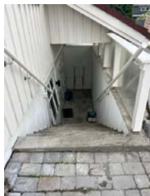
Hybel B - Vestside: Utvendig kjellertrapp.
