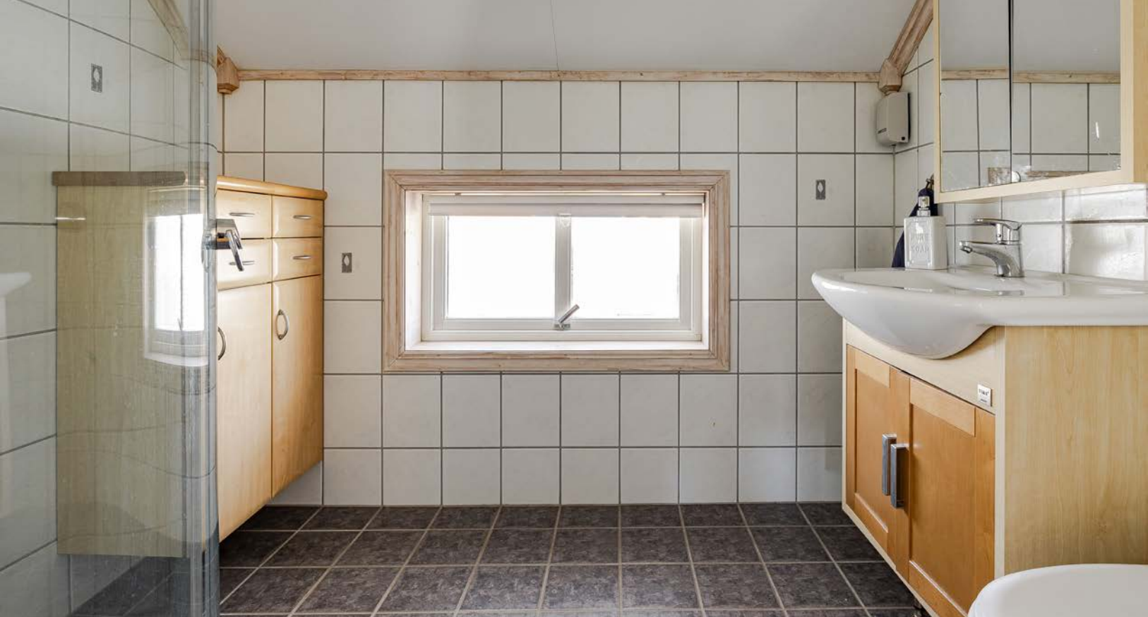
Vegg-i-vegg ligger baderom 2, som også er et pent flislagt baderom fra byggeåret 2003. Baderommet har vannbåren gulvvarme (bergvarme) og balansert ventilasjon.
