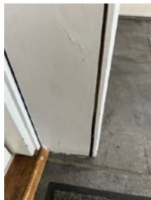
Ytterdør: Innvendig dørutforing og dørlist.
