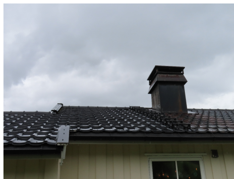
Pipe over tak som helbeslått.
