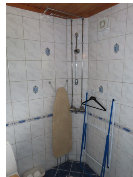
Del av vaskerom - tidligere bad.
