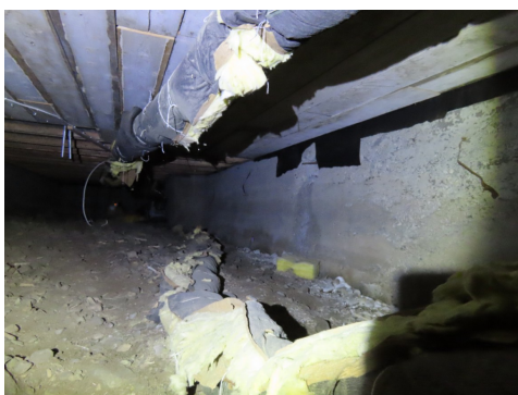
Del av krypkjeller sett fra luke.
