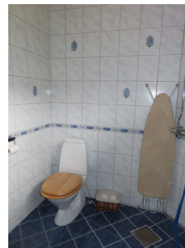
Del av vaskerom - tidligere bad.
