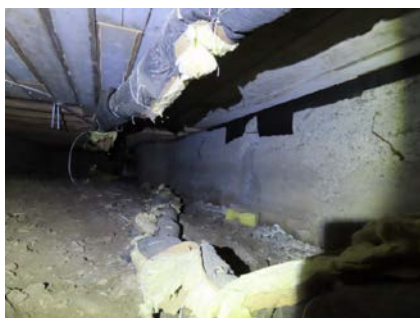
Del av krypkjeller sett fra luke.
