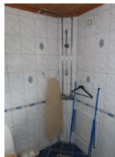
Del av vaskerom - tidligere bad.
