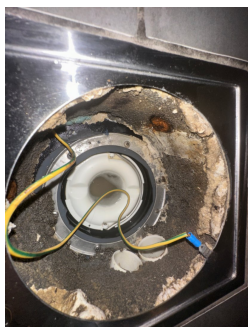
Plastsluk med klemring for membran
