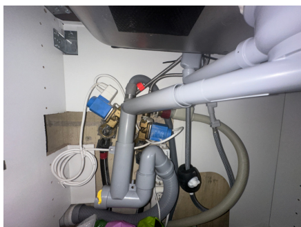
Røropplegg i kjøkkenbenk med Waterguard
