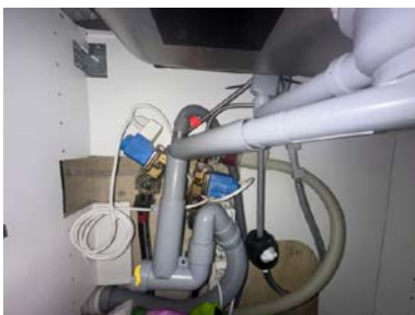
Røropplegg i kjøkkenbenk med Waterguard
