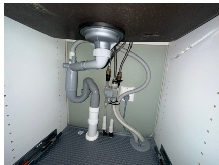
Rørapplegg i kjøkkenbenk med Waterguard
