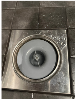
Sluk i plast med vannlås, plassert i dusjnisje
