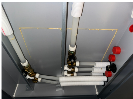
Stoppekraner plassert på bad
